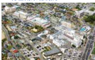
総合南東北病院（福島県郡山市）
