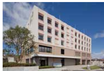
「南東北 BNCT 研究センター」は、南東北病院グループの中核施設「総合南東北病院 (福島県郡山市)」に、「南東北がん陽子線治療センター」と隣接して建設されました。
